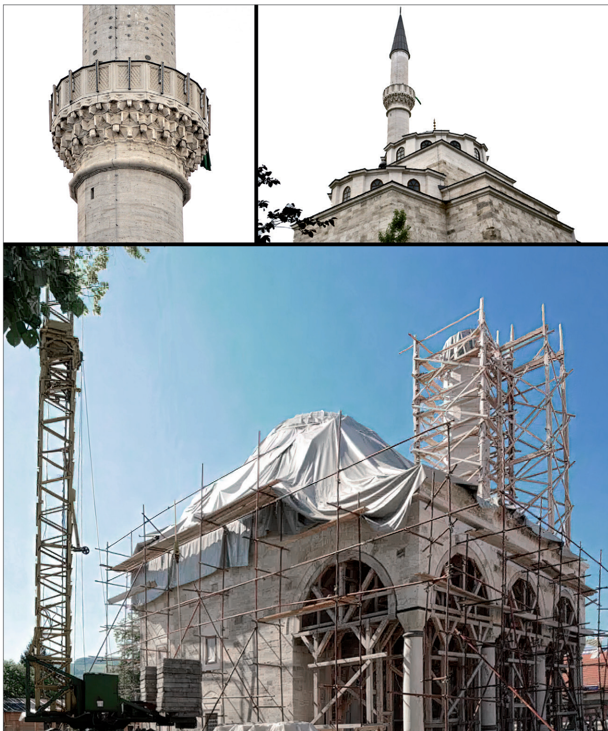
ILUSTRACIJA – Fotodokumentacija dijela rekonstrukcije objekta sa početkom zidanja munare. Detalj šerefeta i izidane munare.
